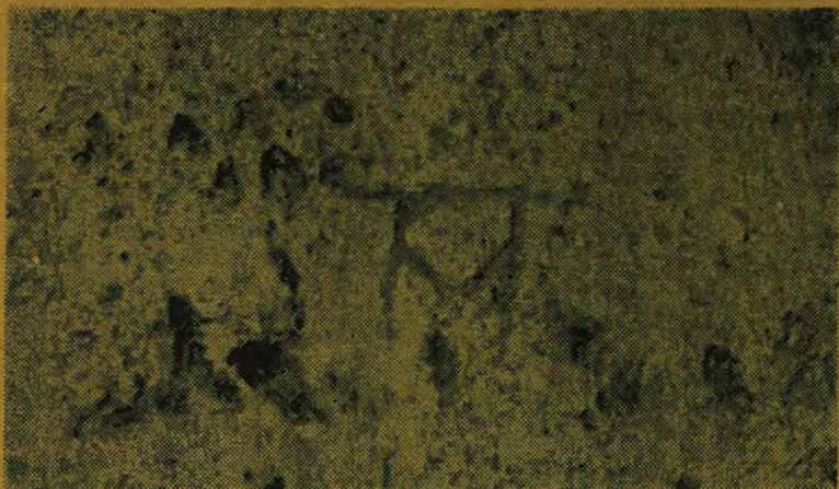
En la ventana de la escalera de los Virreyes aparece esta "A" antigua como marca de cantero.
